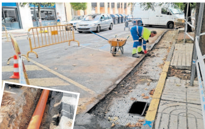
Un operario cubre la tubería con el nuevo imbornal. En el detalle, imagen de la cañería antes de ser cubierta. J. V. ARNELAS Y HOY
